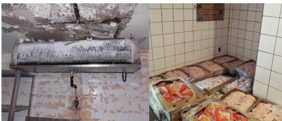
Figura 5 – Teto da câmara frigorífica de carnes. UFF, RU, 11/09/2012.
