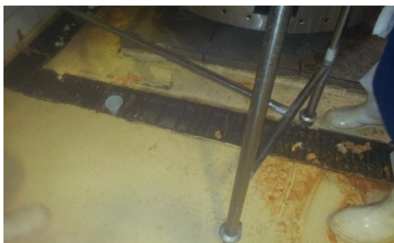
Figura 21 - Grelha da área de caldeirões. UFF, RU, 26/09/2012.
