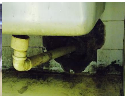
Figura 12 - Instalação da cuba da área de higienização de panelas. UFF, RU, 11/09/2012.
