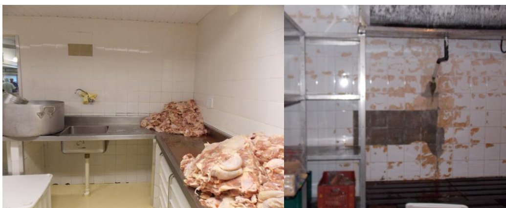
Figura 3 - área de pré-preparo de carnes, antes reforma da área física. UFF, RU, 11/09/2012.
