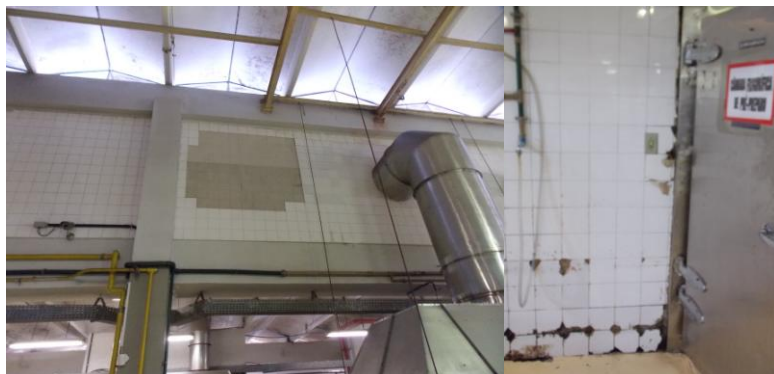
Figura 13 - Revestimento da parede da área de produção. UFF, RU, 11/09/2012.
