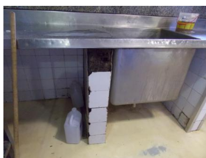
Figura 11 - Área de higienização de panelas. UFF, RU, 11/09/2012.
