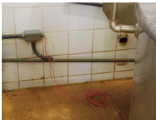
Figura 9 - Instalação elétrica do caldeirão. UFF, RU, 11/09/2012.
