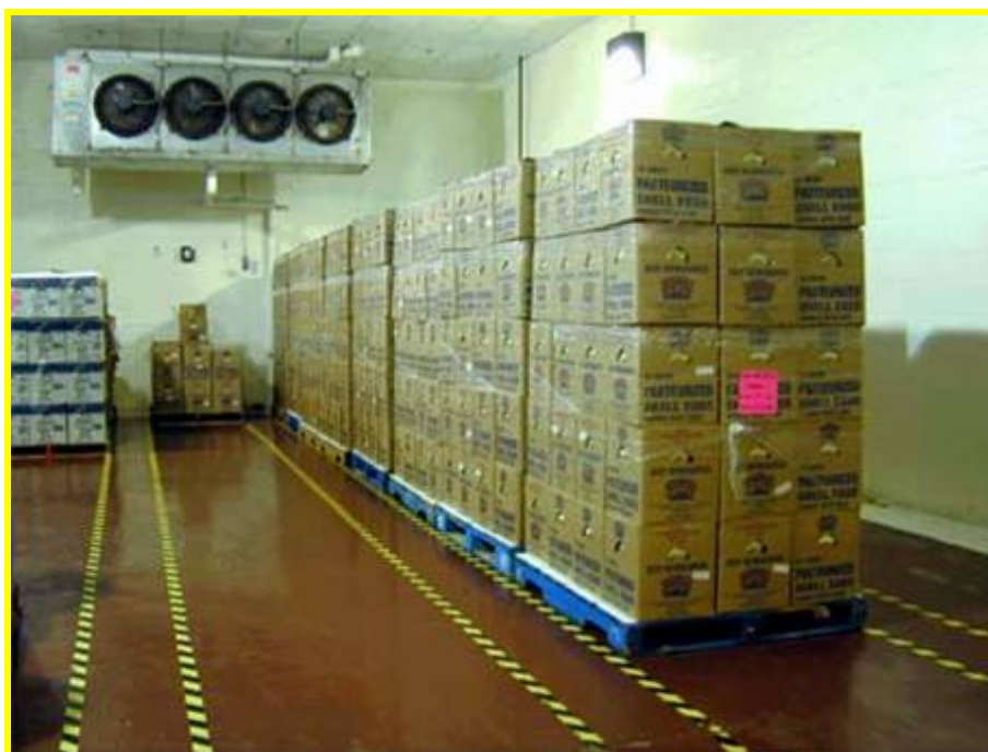
Anexo 10. Processo de pasteurização em casca - Os ovos são embalados, rotulados e estocados sob refrigeração e uma temperatura precisa e ideal de 7,22°C.
