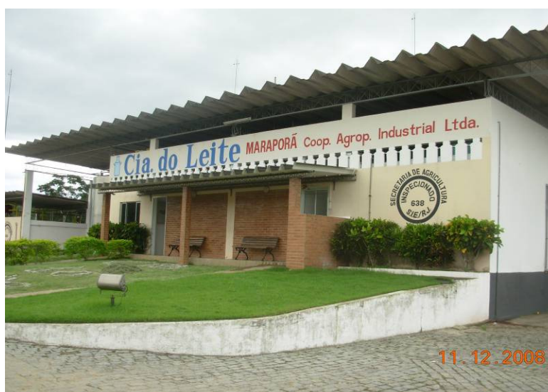
Figura 3 – Vista frontal da CIA do leite localizada em Cachoeiras de Macacu, RJ, Brasil.
