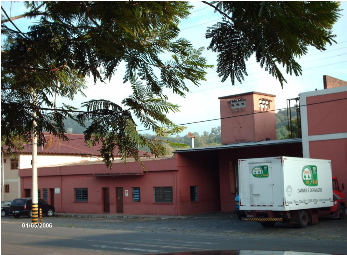
Matadouro-frigorífico em Harmonia-RS - SIF 0459
